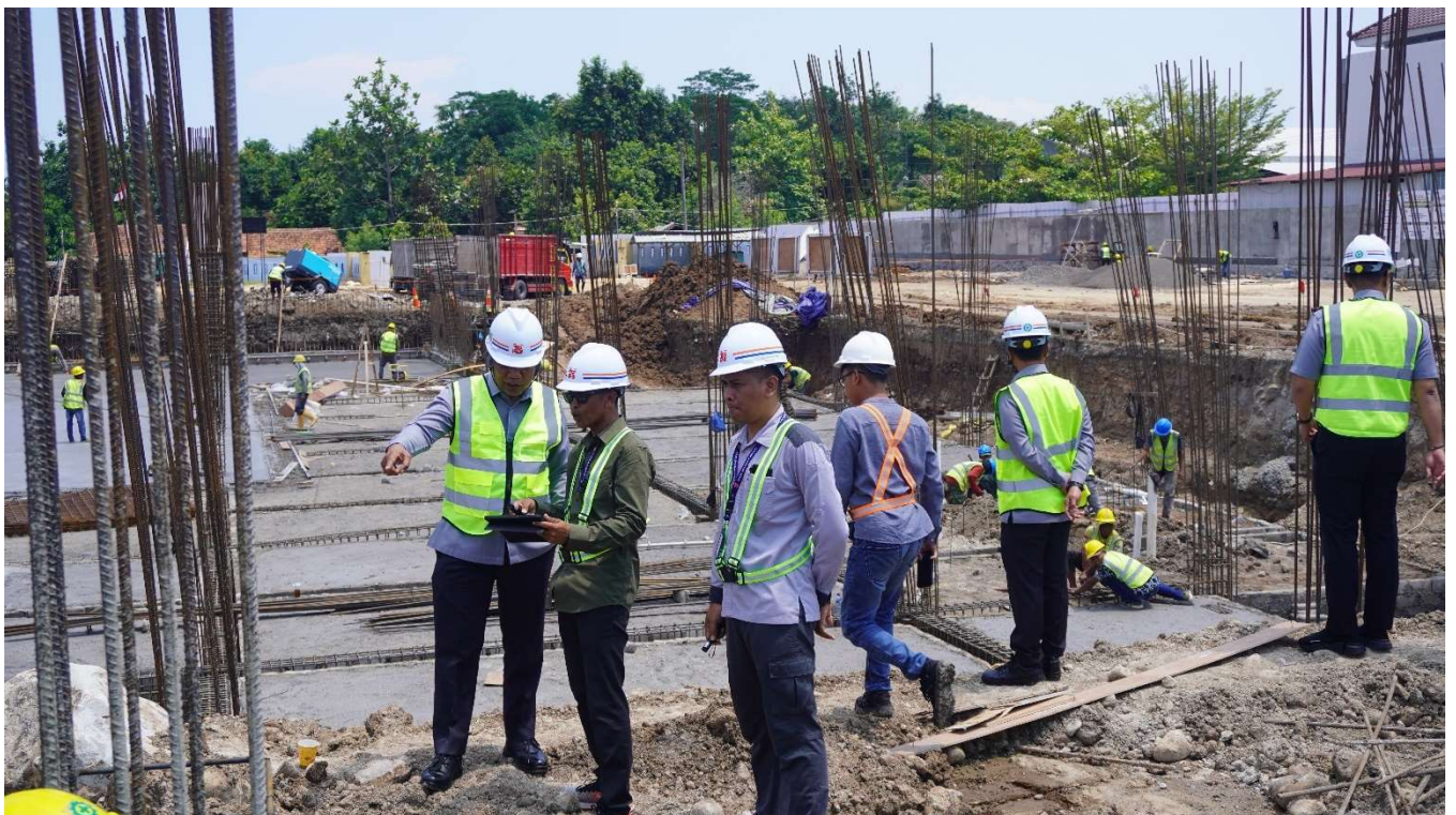
Proses Pembangunan Gedung Baru Kantor Imigrasi Kelas I Khusus TPI Semarang Yang beralamat di Jl.Tugu Lapangan, Semarang
